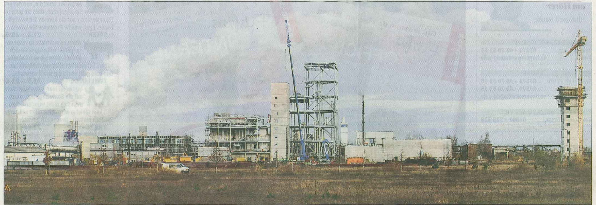
Links dampfen die beiden Kühltürme des Vattenfall-Kraftwerkes. In der Nähe entsteht die Silizium-Fabrik der Schmid Pilot Production. Aus metallurgischem Silizium und Trichlorsilan wird zunächst das Gas Monosilan. Einen Teil wird der Industriegas-Produzent Linde abnehmen. Dem Rest wird in der Pyrolyse Wasserstoff entzogen, so dass Reinstsilizium entsteht.
