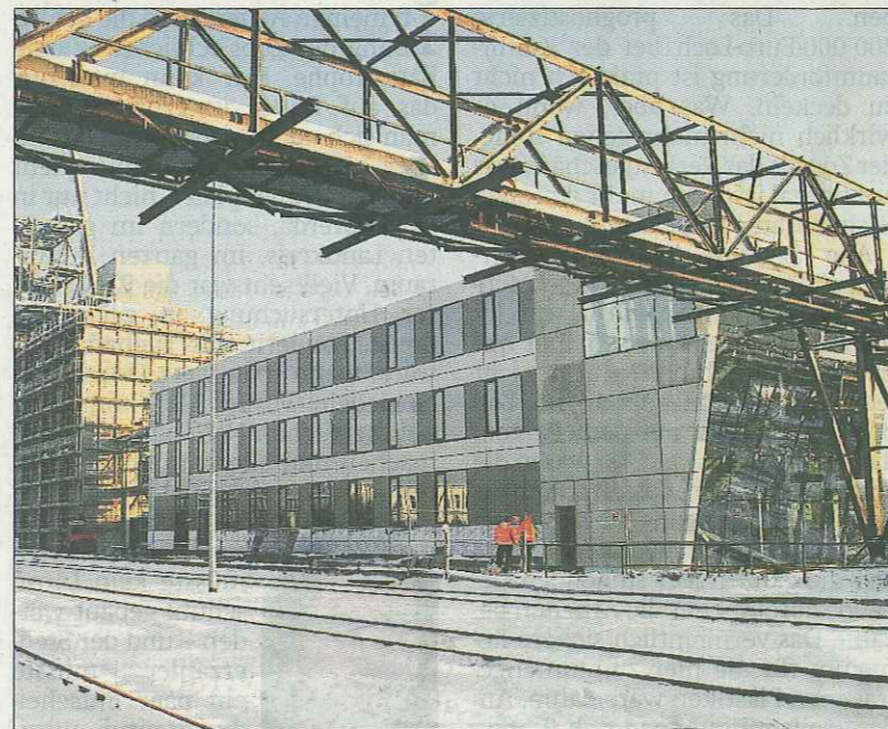
Den ehemaligen Sustec-Verwaltungssitz hat die Schmid Pilot Production zum Labor-, Werkstatt und Bürogebäude umbauen lassen.
