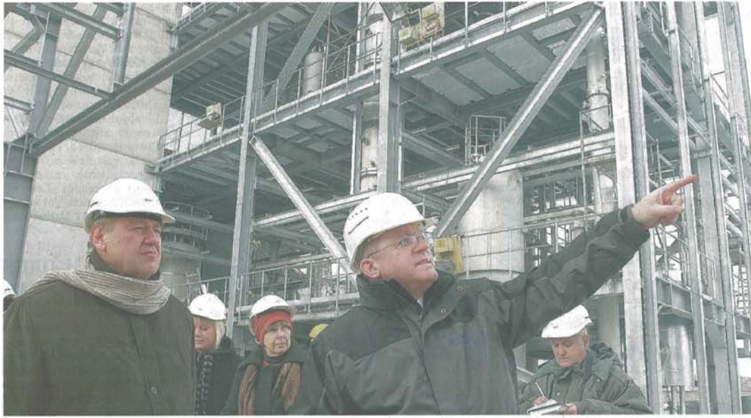
SPP-Geschäftsführer Josef Biedermann (r.) zeigt Mitarbeitern der Arbeitsverwaltungen der Region die Baustelle der Silizium-Pilotfabrik in Schwarze Pumpe (Spree-Neiße). Foto: Martina Arlt.
